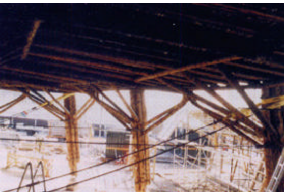
28) "Bild 30. Rahmentest-Schrägzug der Emporenebene"
